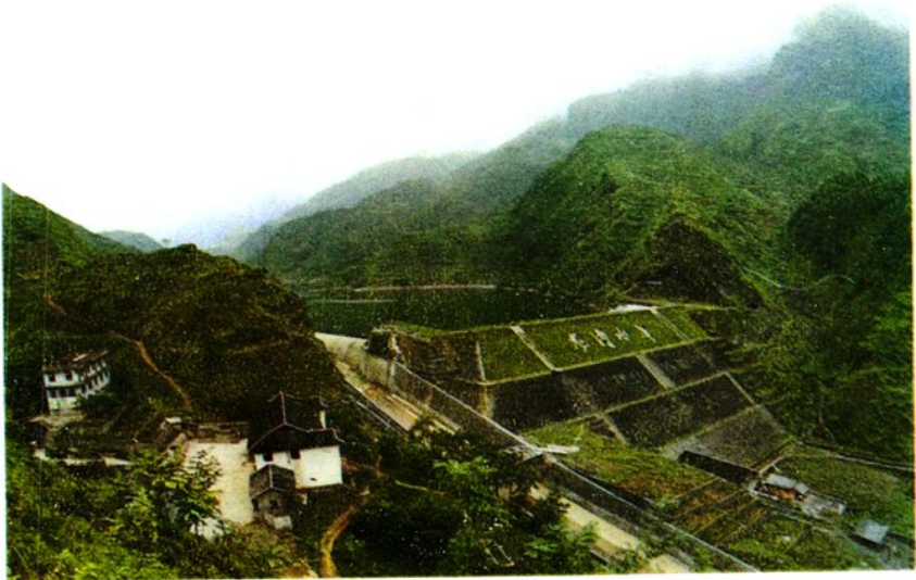
酉阳县龙潭水库。
