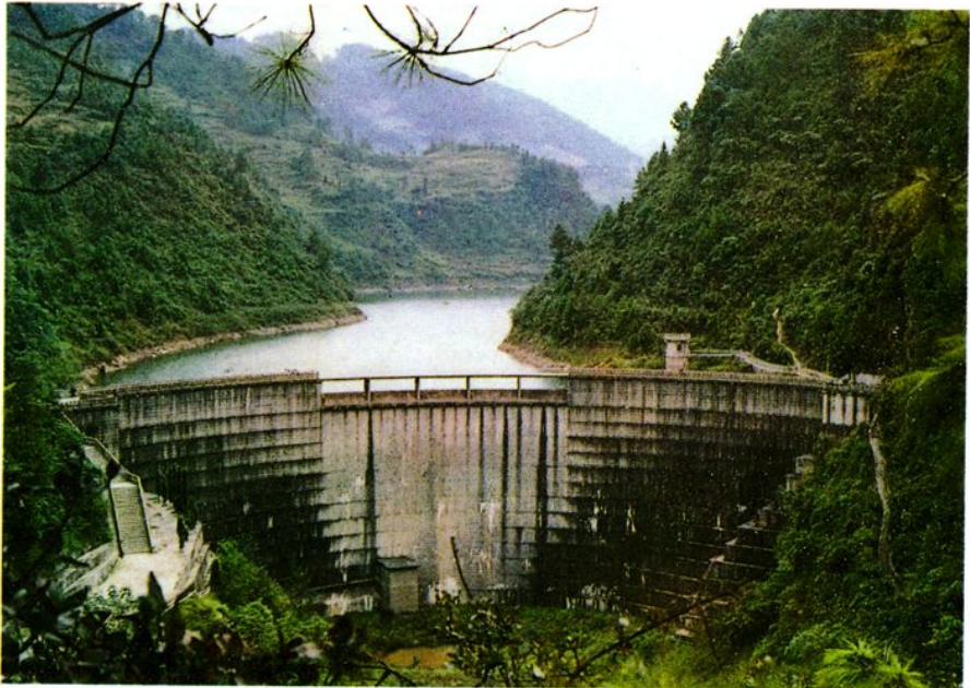
武隆县山虎关水库大坝。
