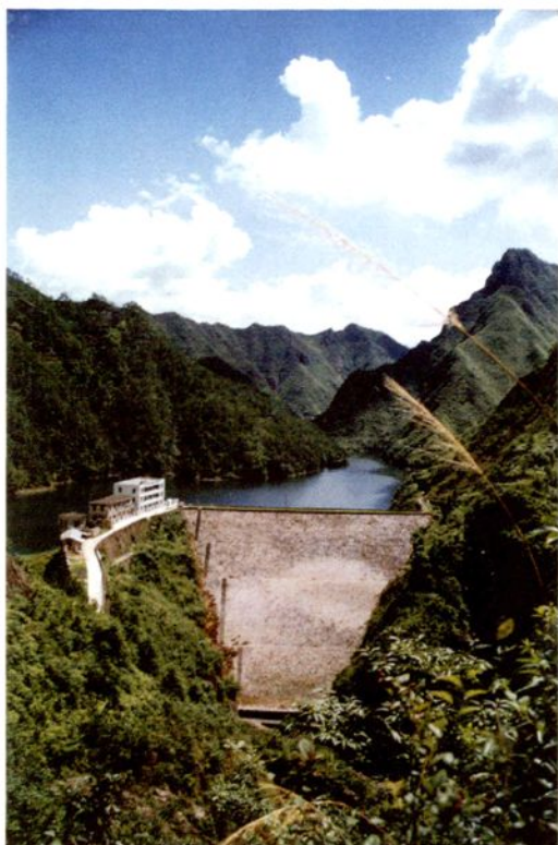
福溪水库大坝背水面
