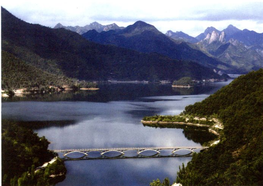
建于 1971 年的淡溪水库牛湾大桥
