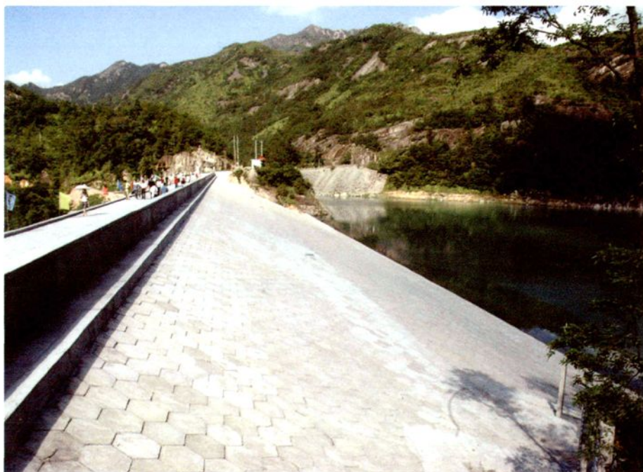
除险加固后的白石水库大坝迎水面
