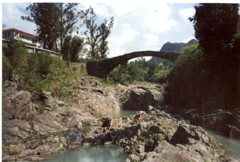
钟前水库溢洪道
