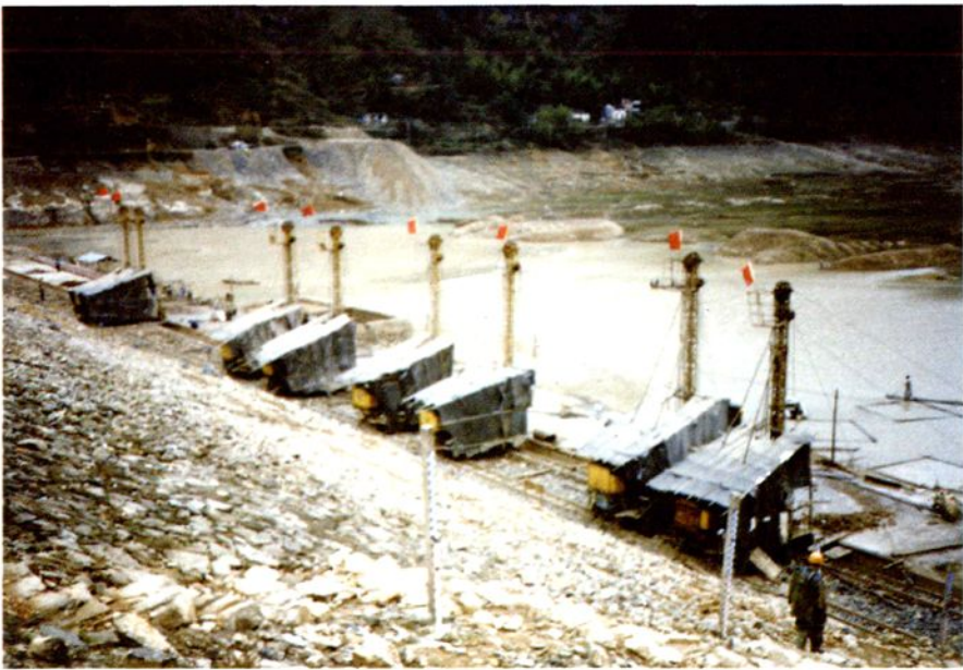
淡溪水库大坝防渗墙在施工中(1993 年)
