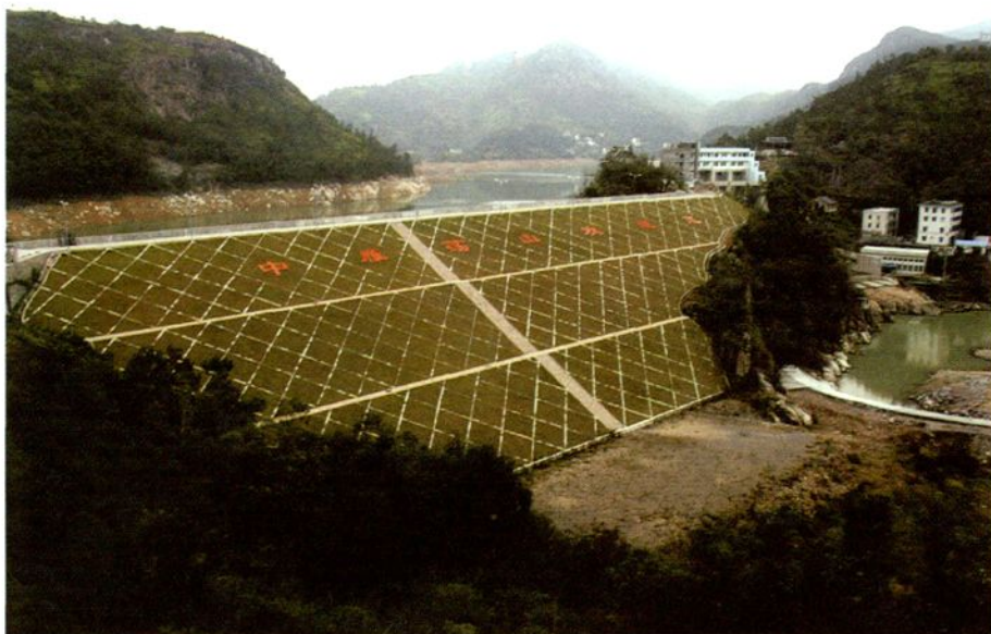
除险加固后的白石水库大坝背水面
