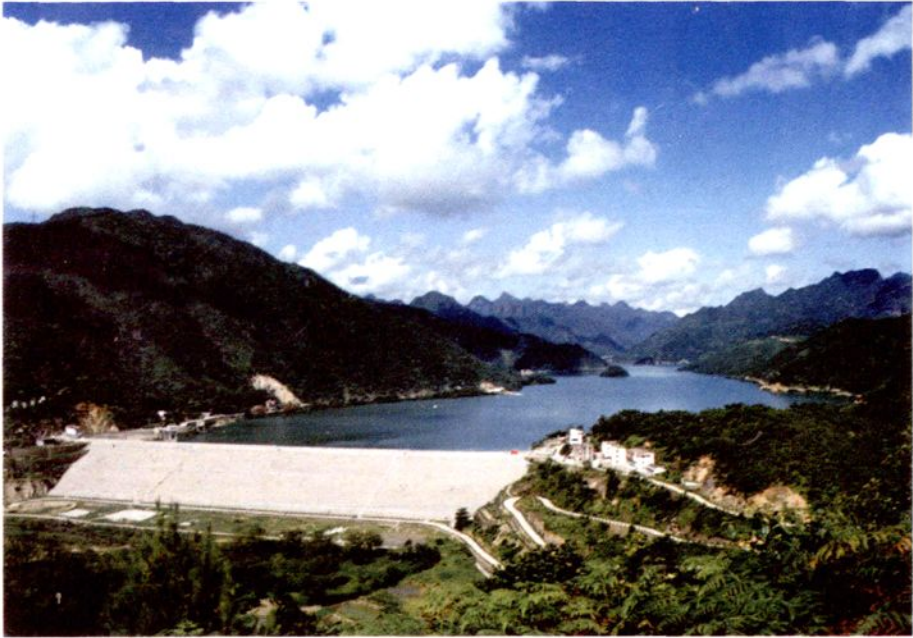
淡溪水库大坝
