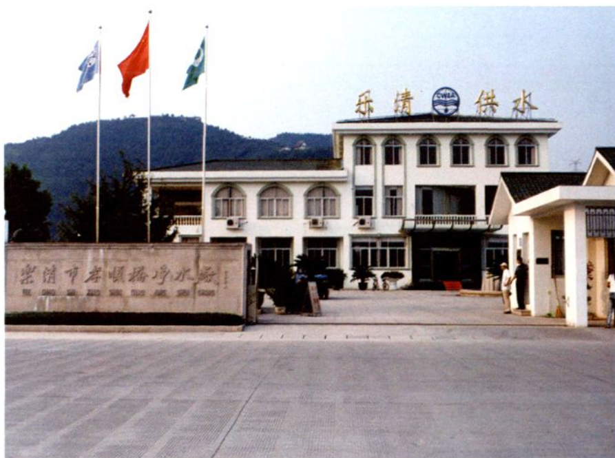
由淡溪水库供水的孝顺桥净水厂
