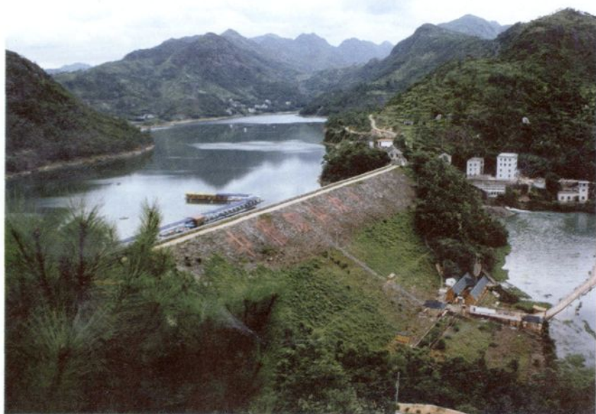
白石水库大坝(1997 年)
