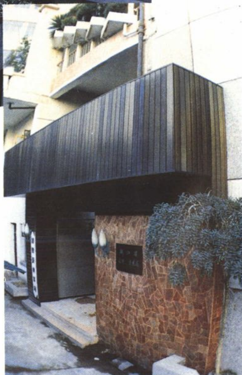
商业局机关办公大楼
