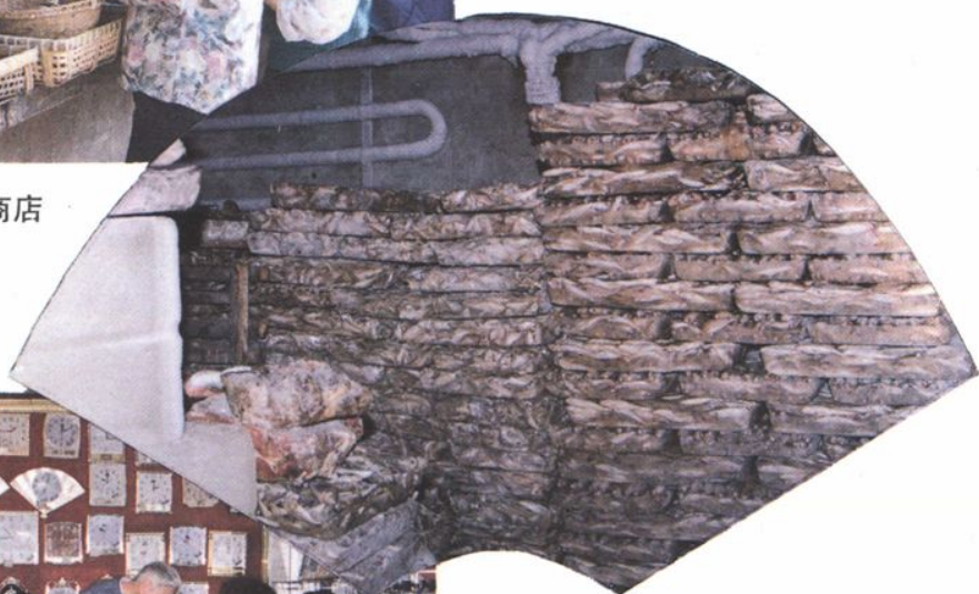
水产公司冷库一角
