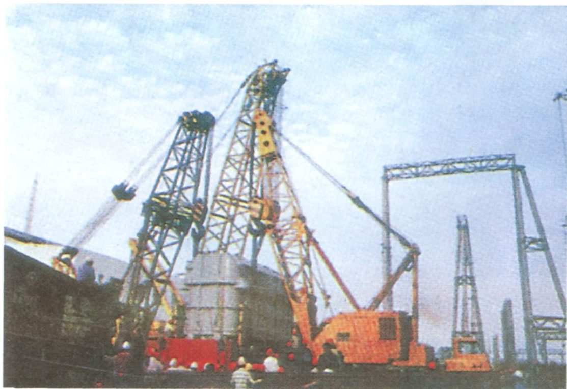
19、1994年9月16日，第一批大件设备(汽轮发电机、主变压器、辅助变压器、锅炉钢架)运抵施工现场
