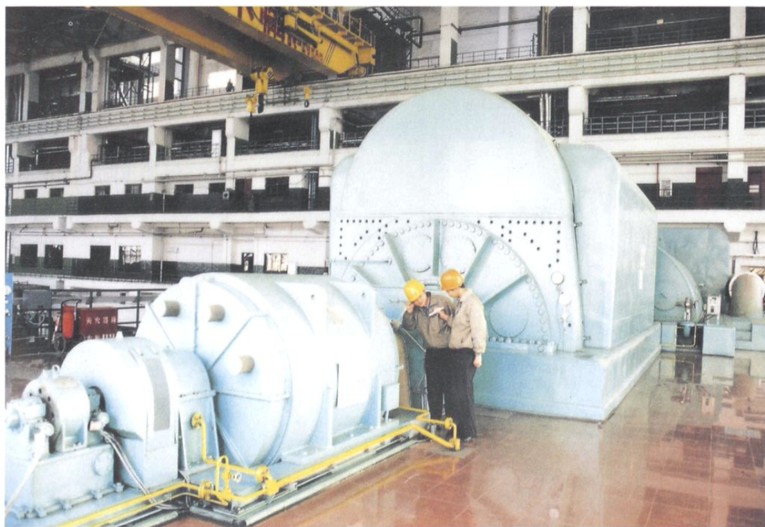
10、从罗马尼亚进口的2X330MW汽轮发电机
