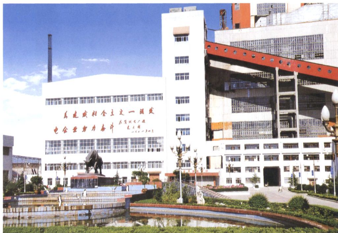
2、蒲电一期工程汽机、锅炉房
