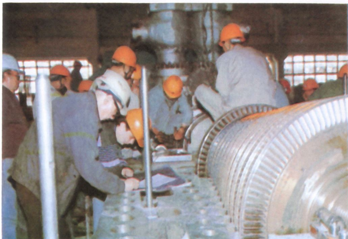
22、罗马尼亚专家在生产现场指导设备安装调试
