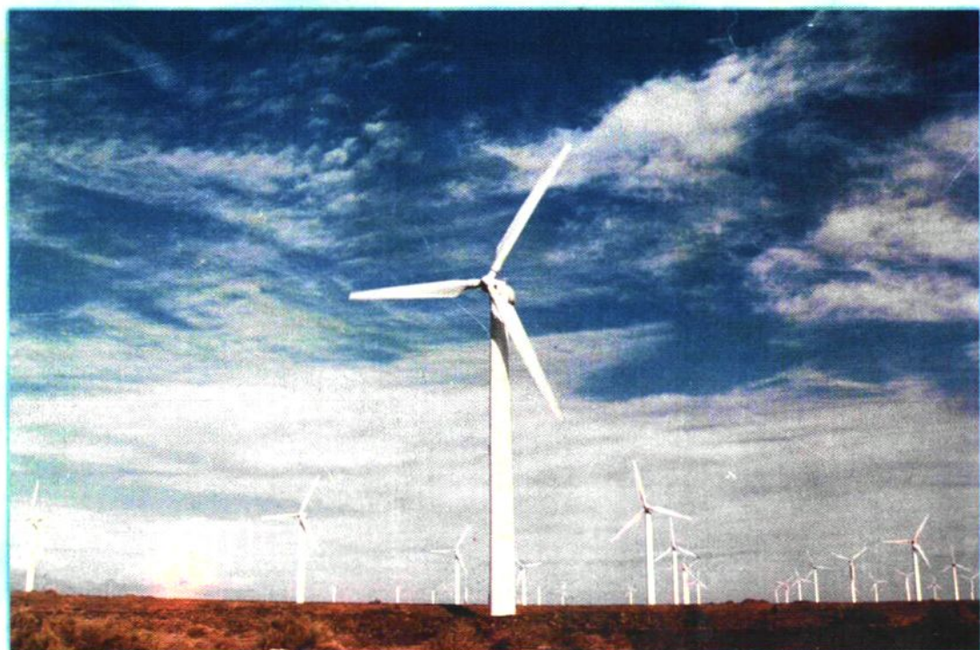
工商银行新疆区分行积极支持电力事业发展。图为工商银行新疆区分行贷款支持的新疆风能有限公司风力发电厂一角。
