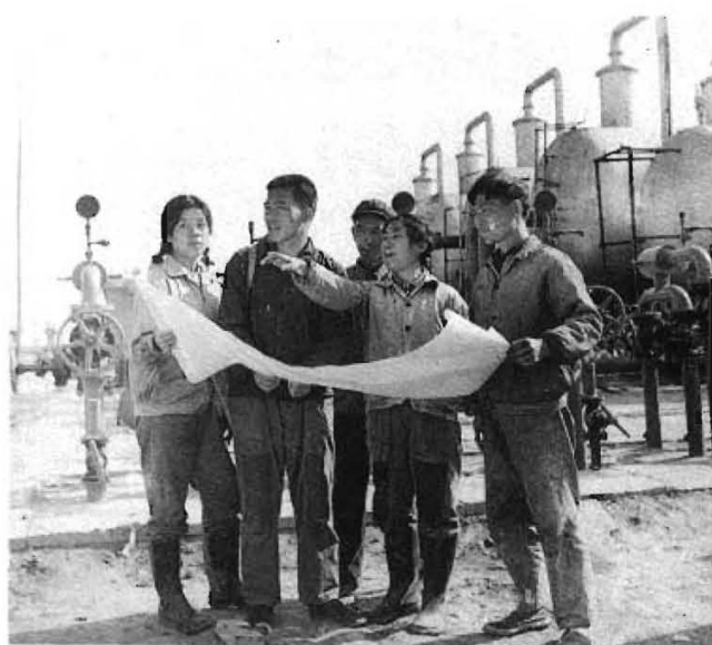
工程技术人员在工地现场组织施工
