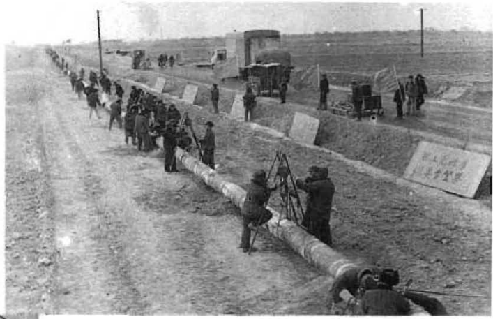
任沧管道建设工地
