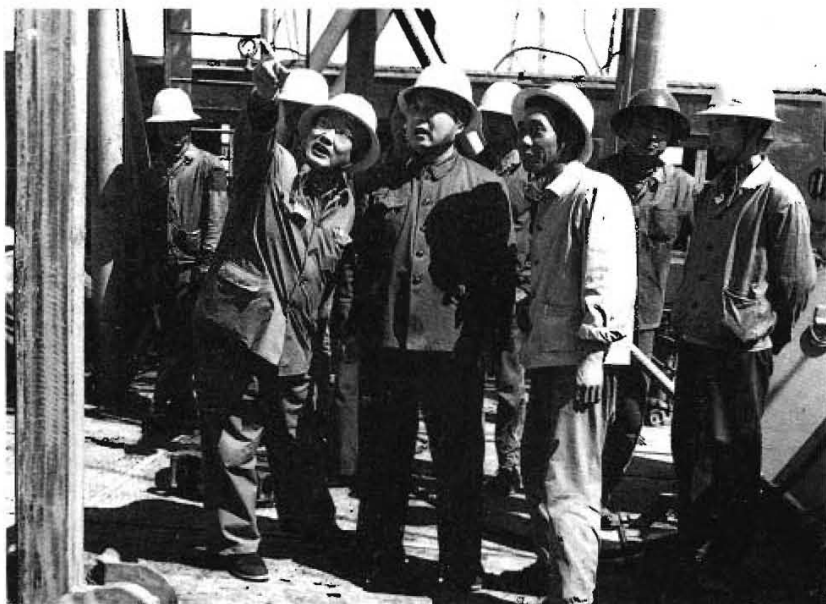
李德生同志在 焦力人副部长陪同 下视察钻井平台
