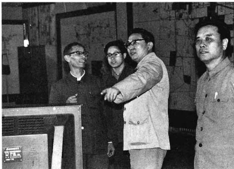
罗干同志考察 水电厂电力调度控 制室
