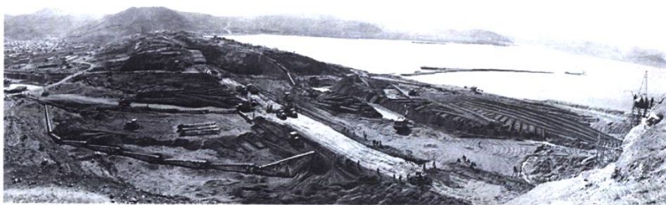
水库施工工地全景
