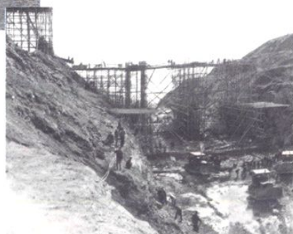
原溢洪道施工现场
