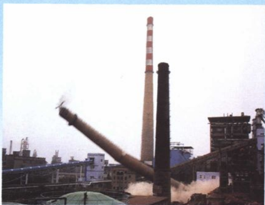
老厂烟囱爆破拆除
