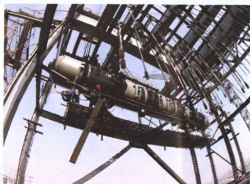
11号锅炉汽包吊装
