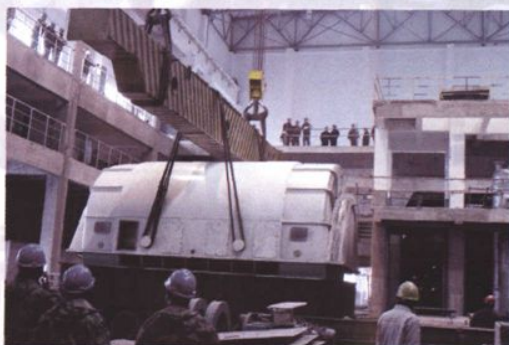
11号发电机定子安装
