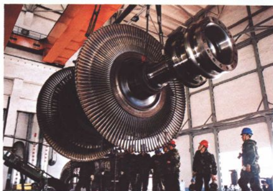
11号汽轮机转子吊装
