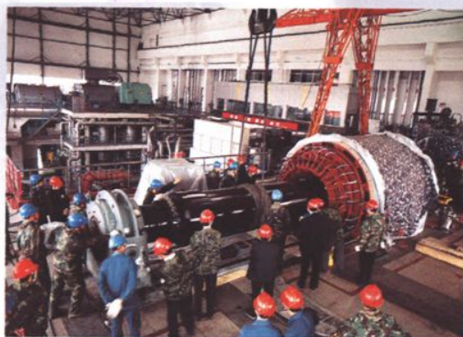
11号发电机定子安装
