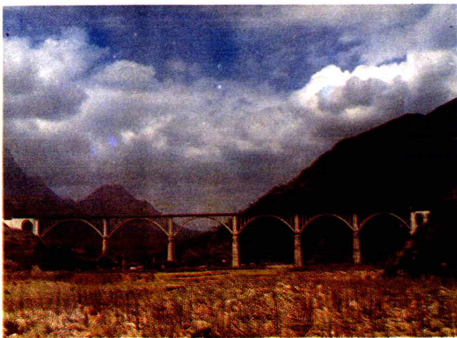
宝成铁路雁门大桥
