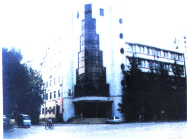
▲ 烟台市卫生防疫站办公大楼
