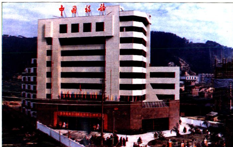
座落在市环城西路 10 号的梧州市税务局 新办公大楼于 1992 年 10 月 30 日落成庆典。
