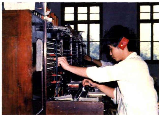
县局长途电话连续台
