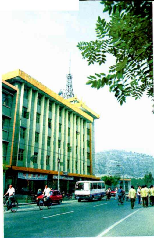
广播电视大楼
