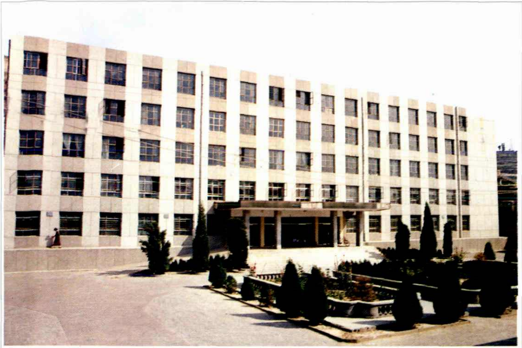
中共绥德县委办公大楼
