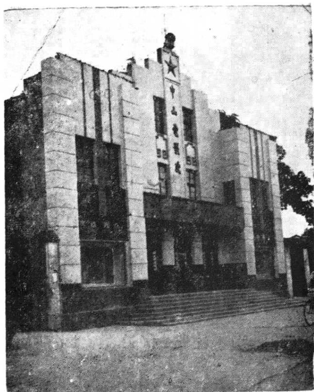
城中心，新扩建的中山电影院外景
