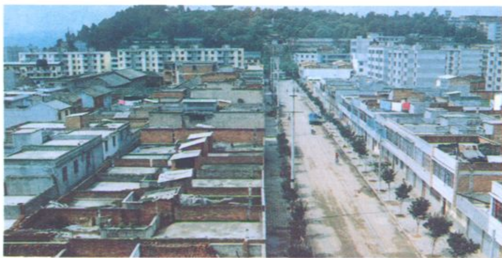
正在建设中的兴阳村民居
