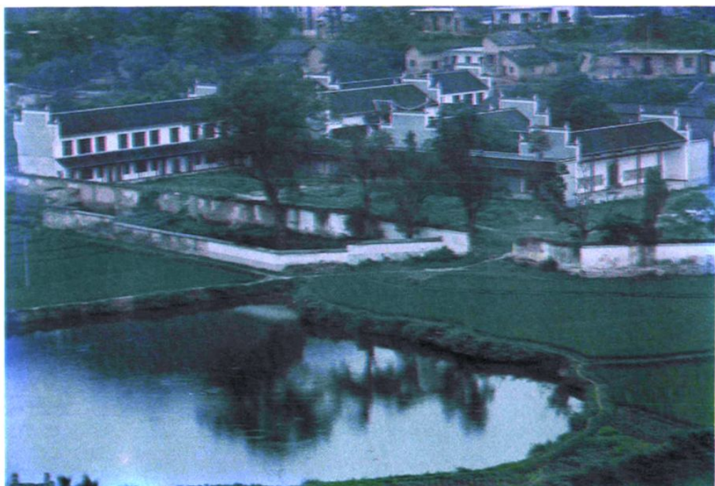
1989 年募捐集资 200 多万元按原貌改建的云山书院(图中近处大坪内并排两竖栋正在筹建之中)
