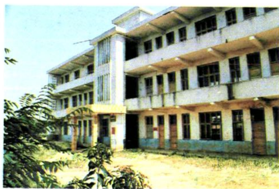
夏铎铺乡农科教中心教学楼
