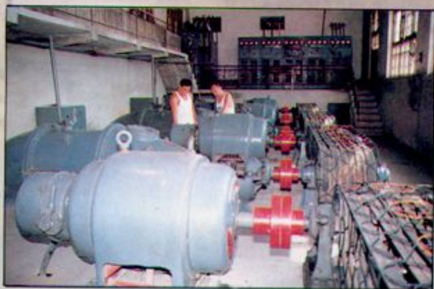
排水机械检修
