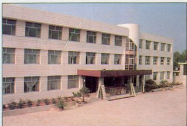
水利局办公楼
