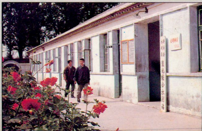
洼地综合水利站
