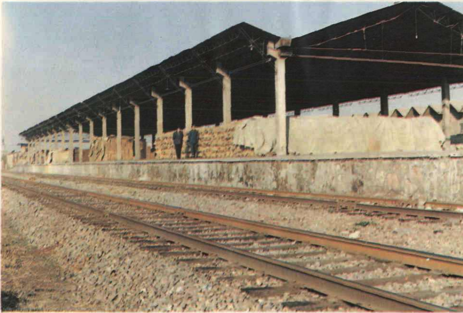
宁夏供销社综合仓库铁路专用线
