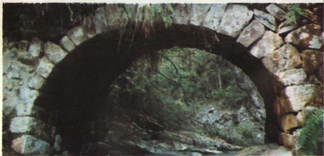
彭坑古石拱桥
