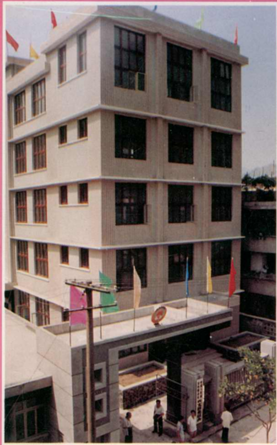
△兴文县政协办公大楼
