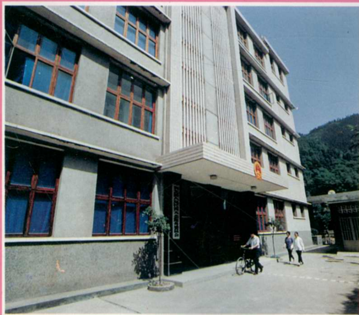
▽兴文县人大办公大楼
