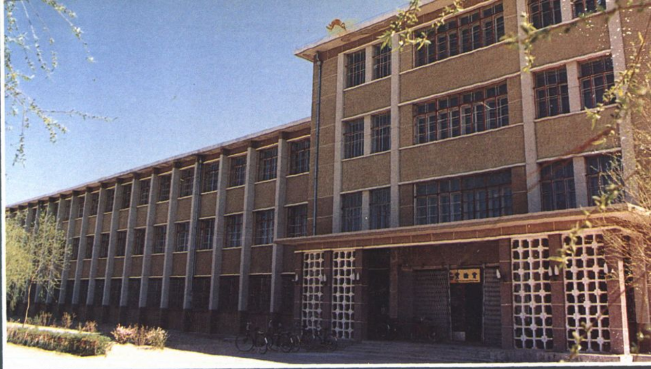
实验楼建于 1982年11月， 建筑面积4396 平方米，共有 19个实验室。 图为实验室一 角。
