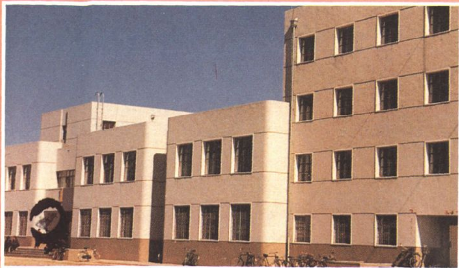
图为实习大队综合楼。建于 1990 年，占地面积 2478 平方米。是钻井安装和井下作业专业进行生产实习教学和教职工办公的重要场所。
