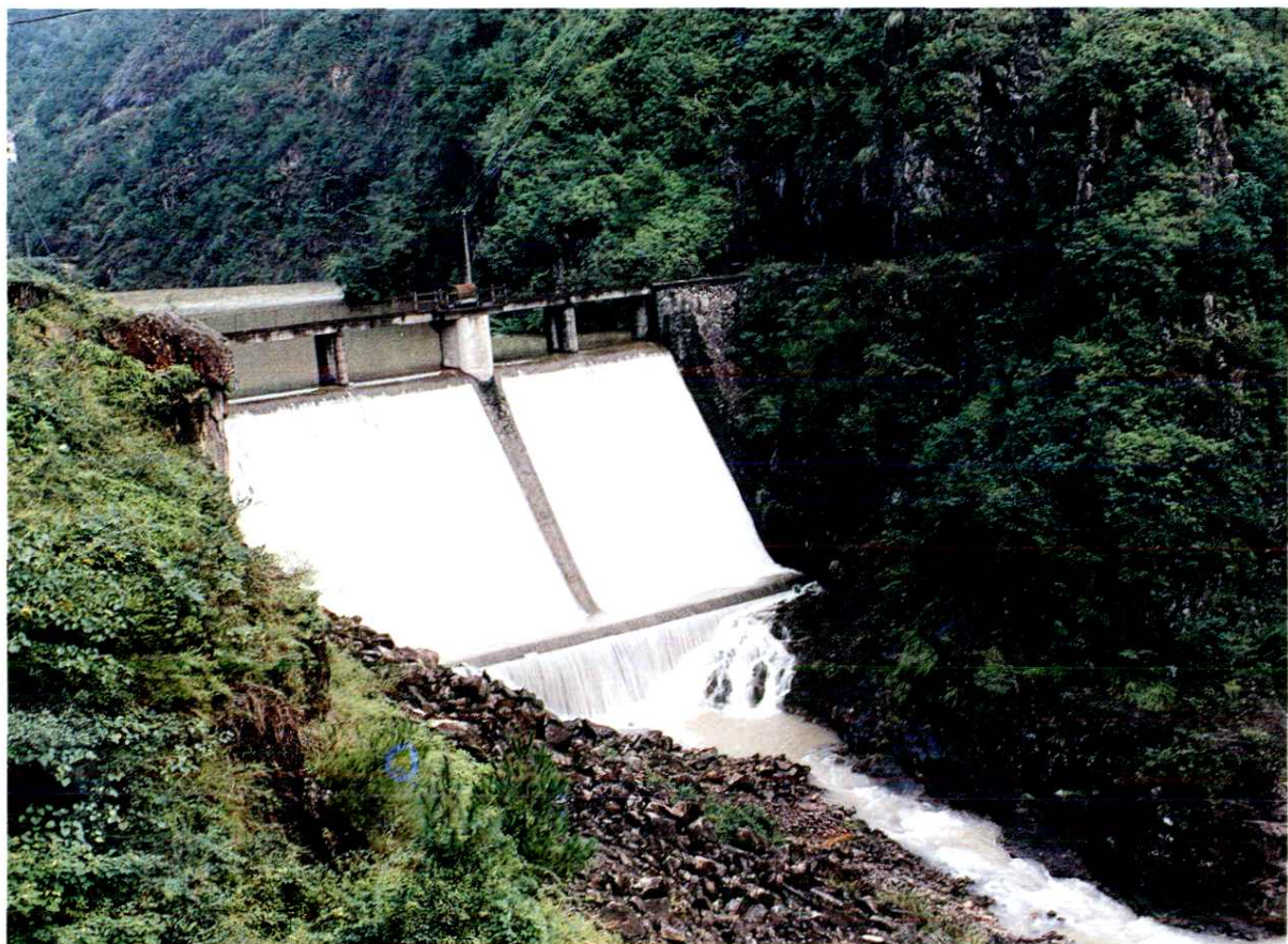
百丈瀑电厂二级站水库干砌石自溢坝
