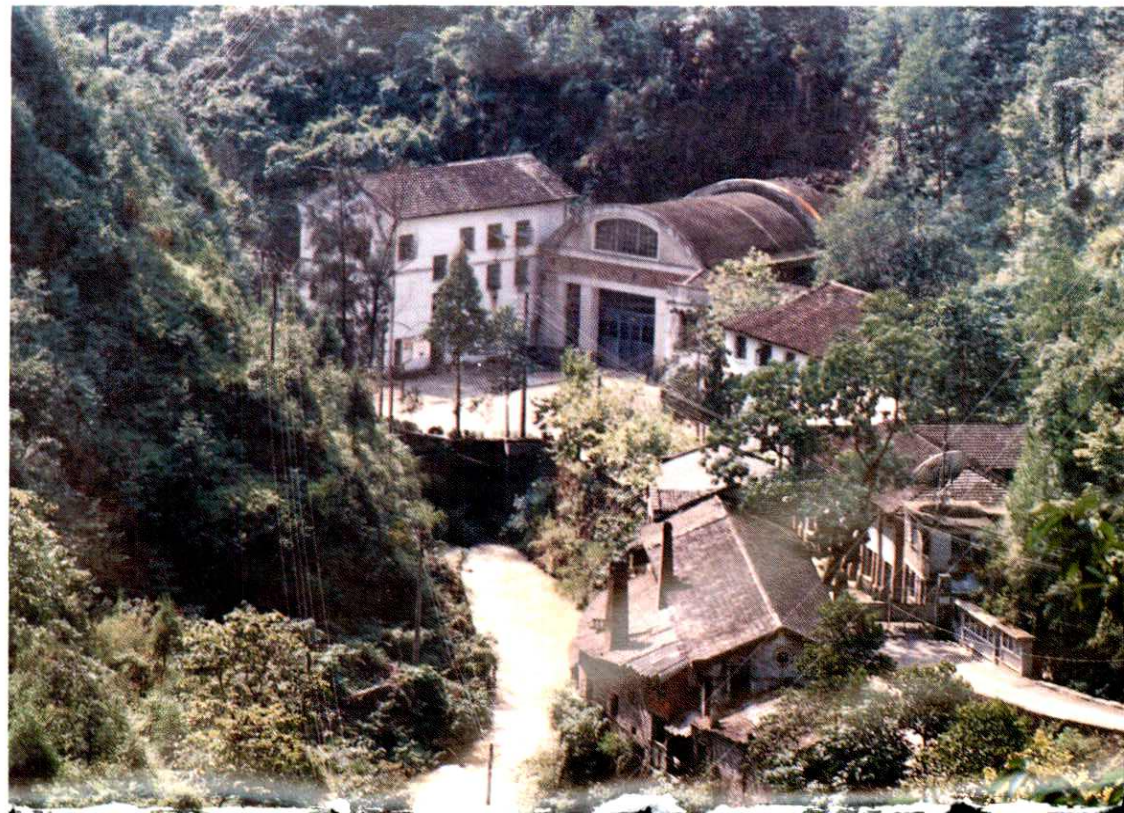
百丈漈水电厂(一级站)半地下式的主厂房
