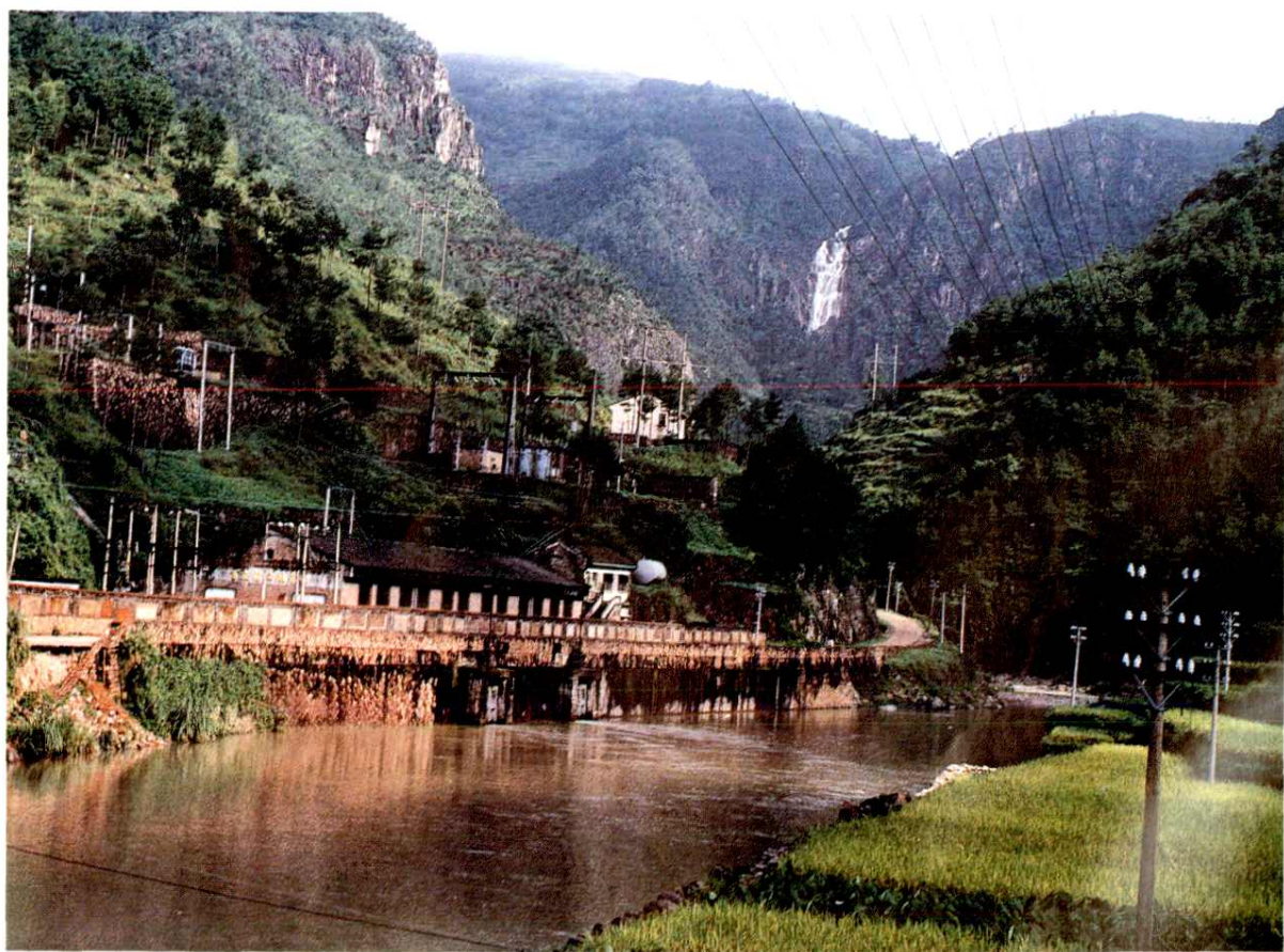
百丈漈电厂二级站外景
