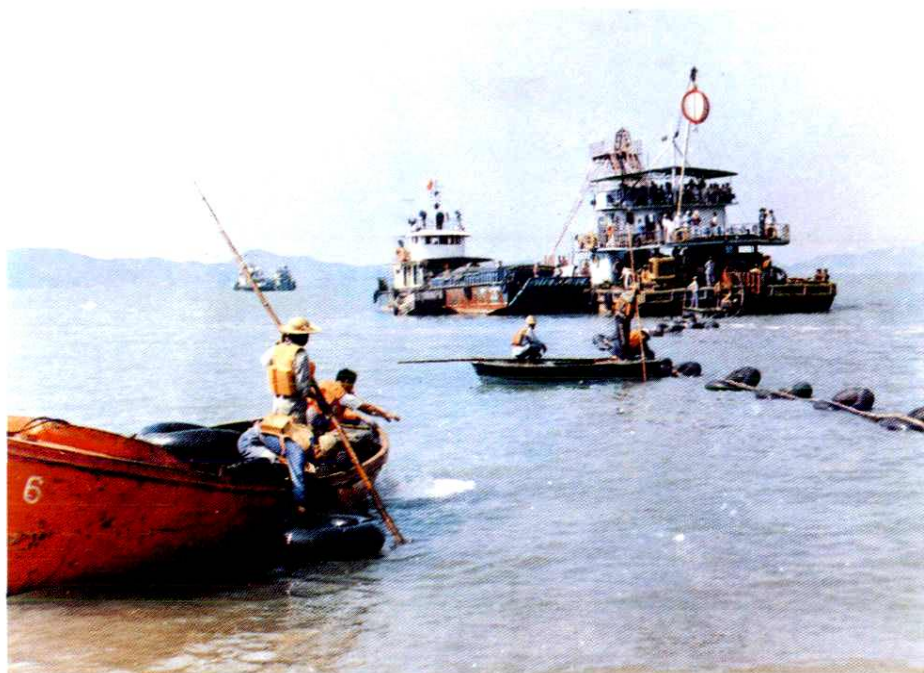
敷设乐清至洞头 35 千伏海底输电电缆
