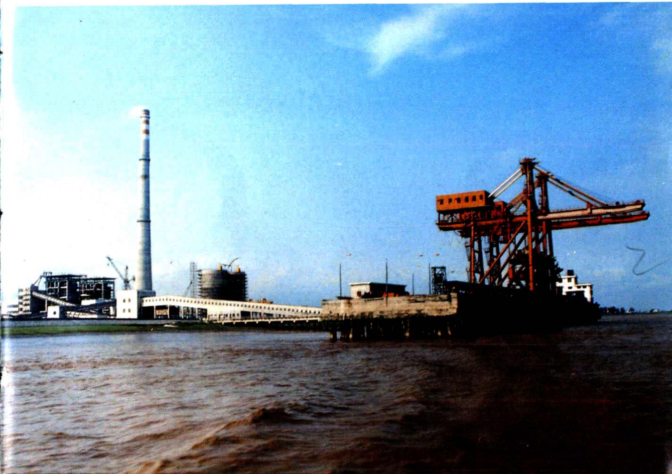
温州发电厂码头
