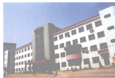
新干县人民医院门诊部
