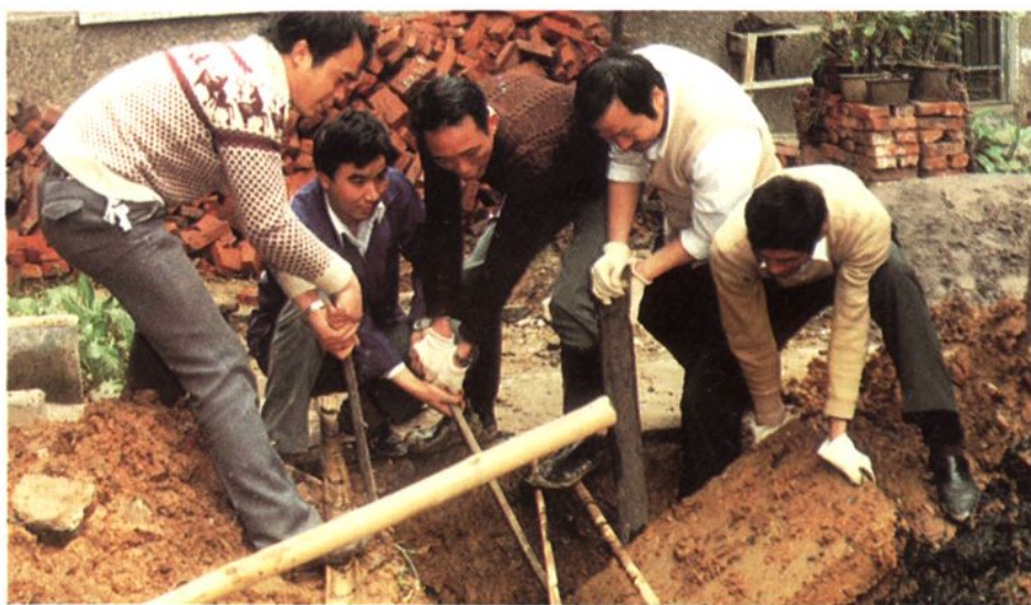
在维修住宅排污管道 ►象山房管所干部、工人
