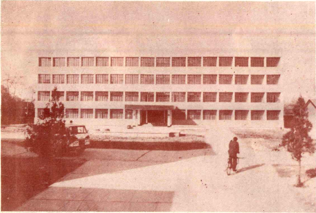
中国共产党确山县委员会办公楼
