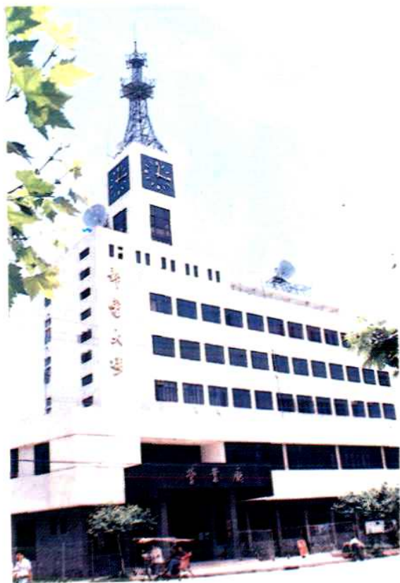
◀ 瑞安市电信综合大楼
