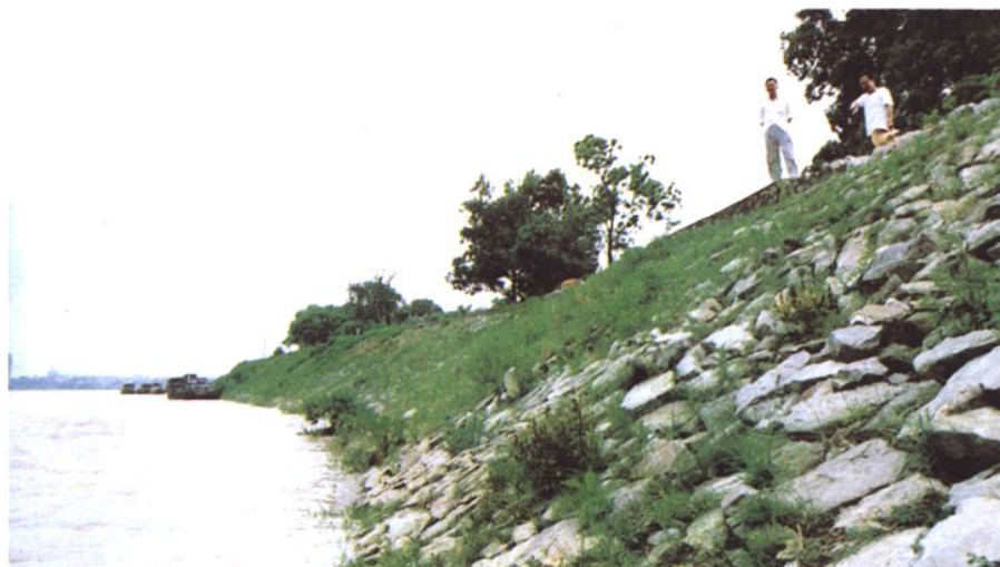
▲省、地、市财政投资兴修的河东沿江护坡
