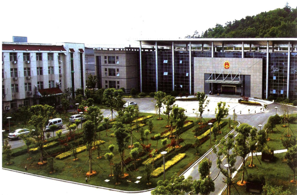
江宁区政府办公大楼
