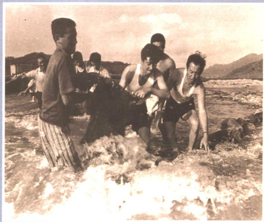
本溪县清河镇干部、 群众奋力堵塞防洪堤决口
