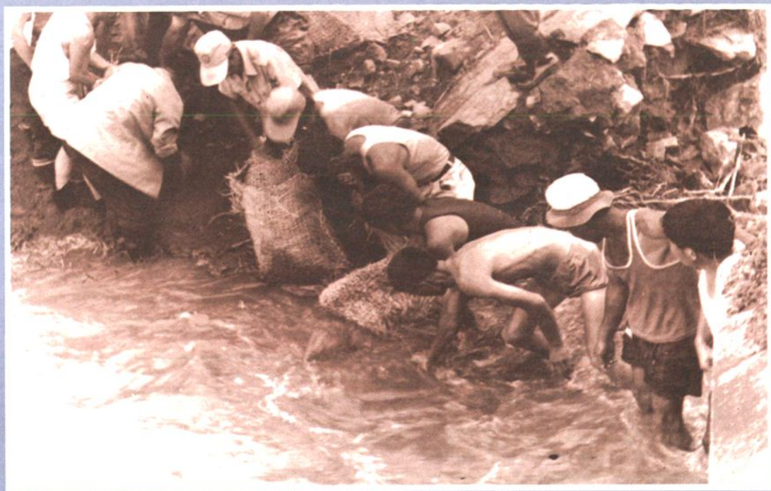
本溪县交通局抢险队和养路工区职工抢修陈英桥引线
