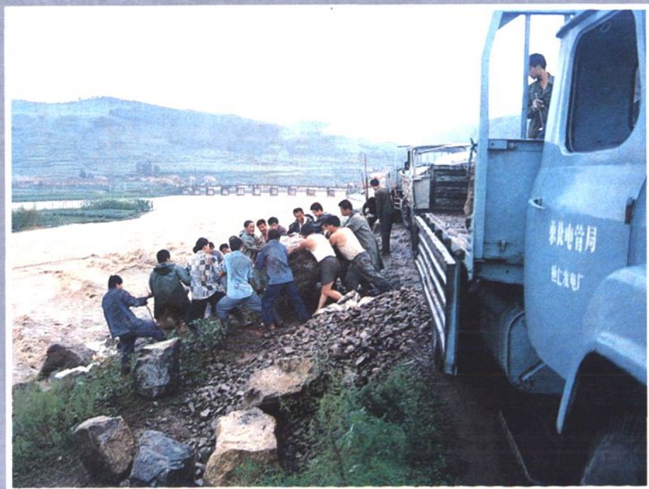
桓仁发电厂抢险队正在紧张地加固哈达河河堤
