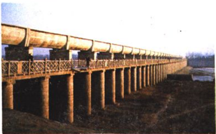
许家崖水库北干渠最大建筑物——姜庄湖渡槽
