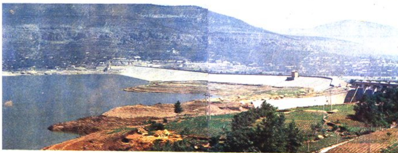
雄伟壮观的许家崖大型水库
