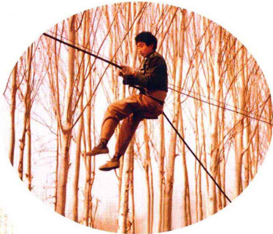
架空光缆施工
