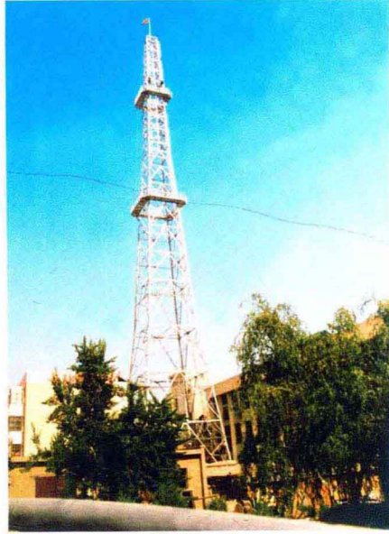
微波通信铁塔
