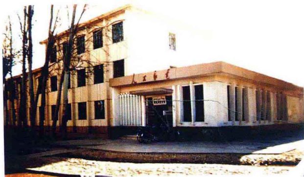
1992 年竣工的皮山县邮电通信楼
