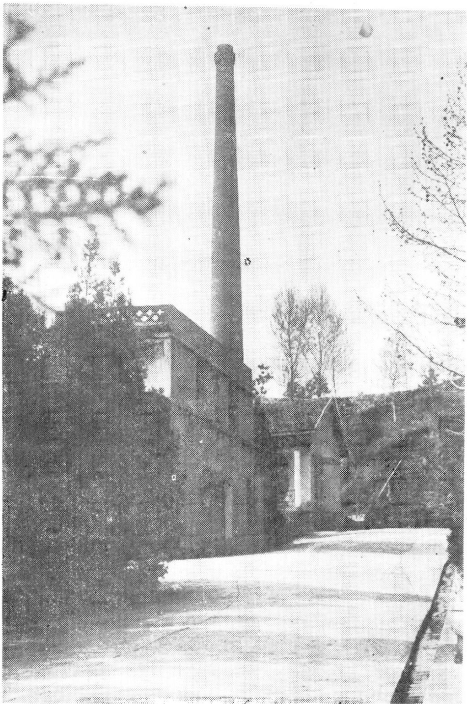
罗田县殡葬管理所的火化车间一角
