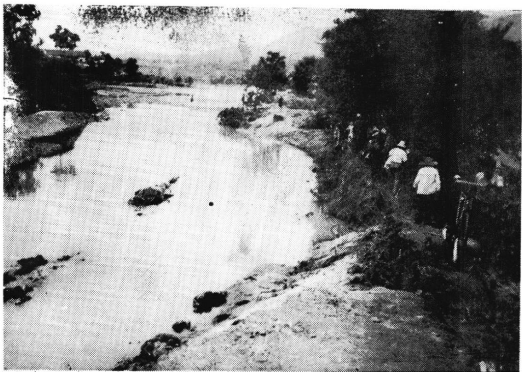
1983年，罗田县遭受巨大洪灾。▲ 图为大河岸公社石井头大队的大片良田被洪水冲成深潭。
