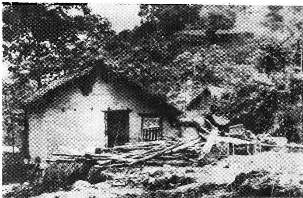
▲ 河铺公社桥头边大队二小队社员张贵廷、张金和两家，屋后山崩，毁房屋十二间，打死三人，重伤三人，轻伤一人。
