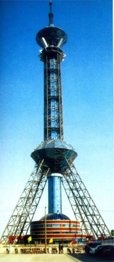
▲ 石家庄电视塔
