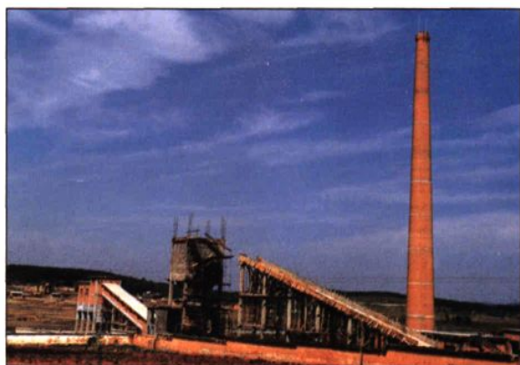
在建中的“七〇”型機焦爐
