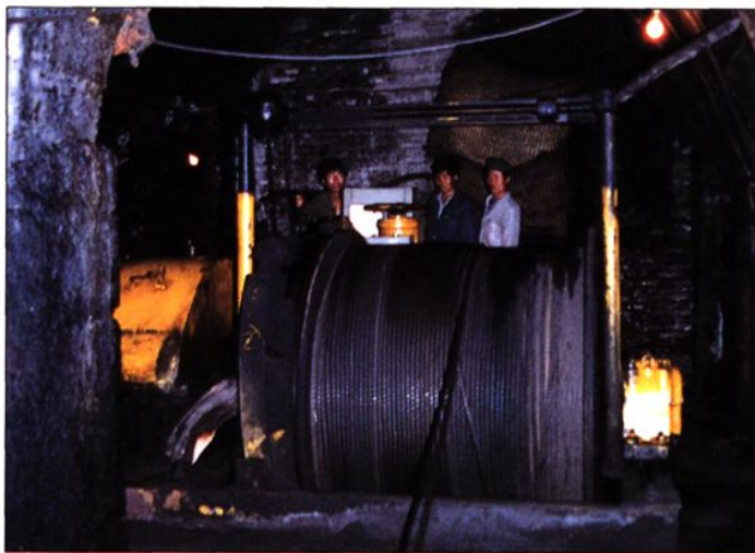
暗斜井絞車硐室
