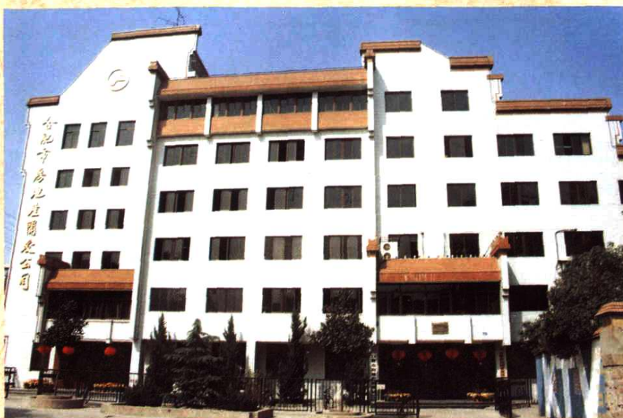
合肥市房地产管理局办公大楼
