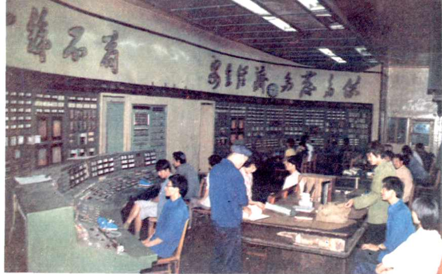
十七、一电站热控室
