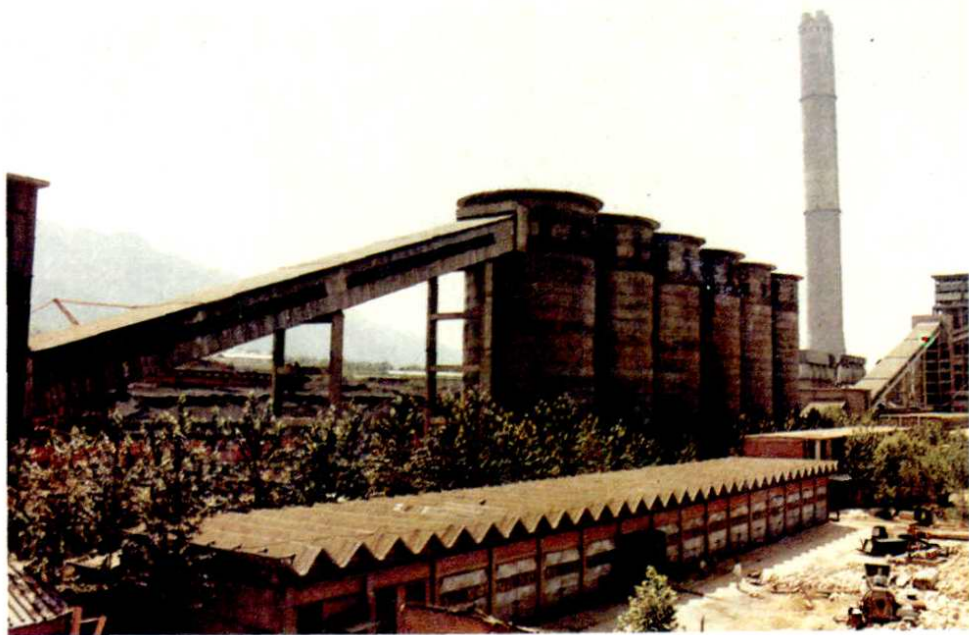
十五、厂区输煤栈桥及圆筒仓
