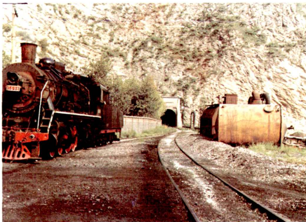
二十三、一期铁路运煤专线隧道
