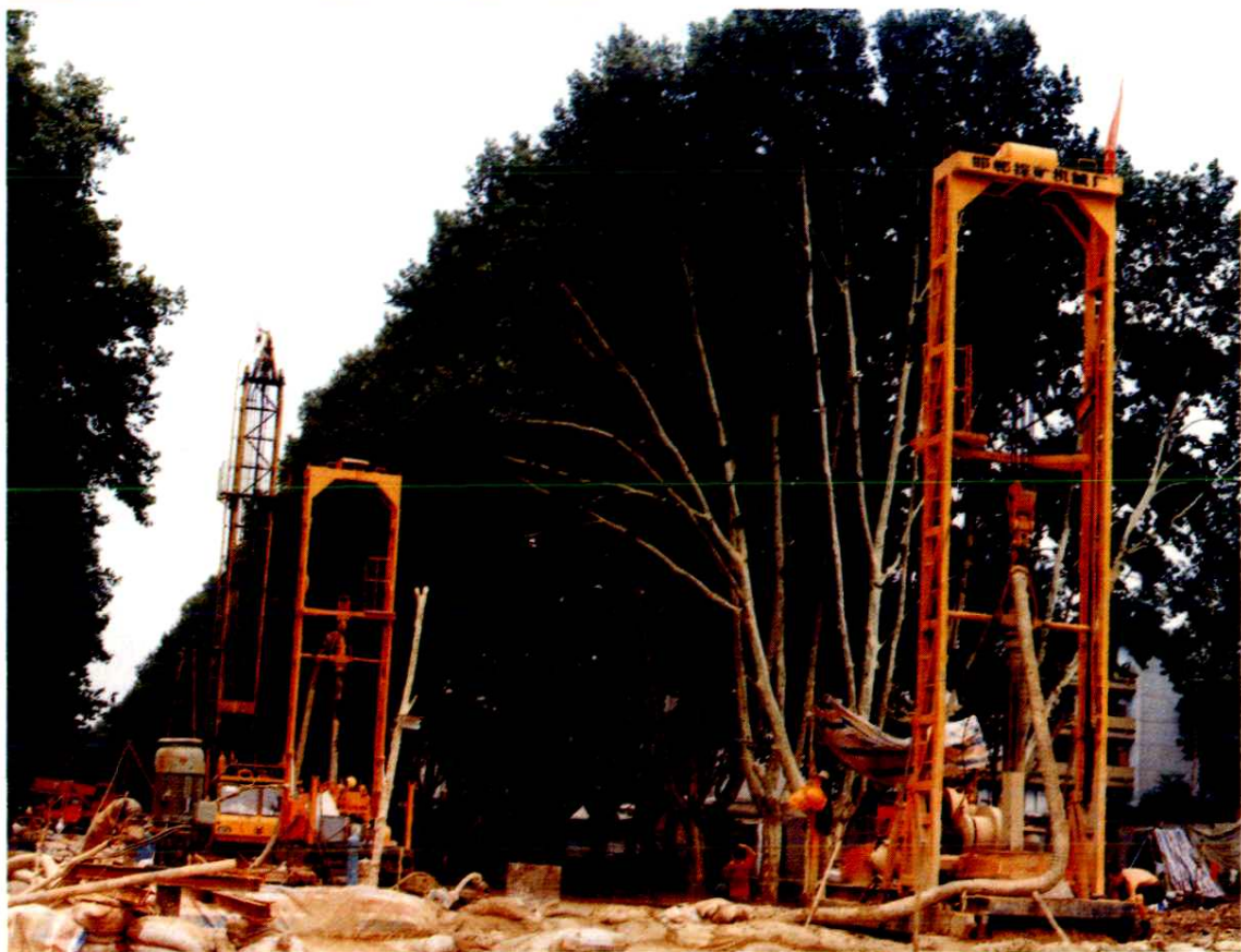
水文地质局 GPF118 桩基钻机（正、反循环）和 GPS115 桩基钻机 （正、反循环）施工灌注扩底桩，直径可达到 2 米以上。图为他们正在 马头电厂施工
