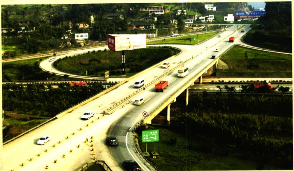
内宜高速宜宾南立交桥
