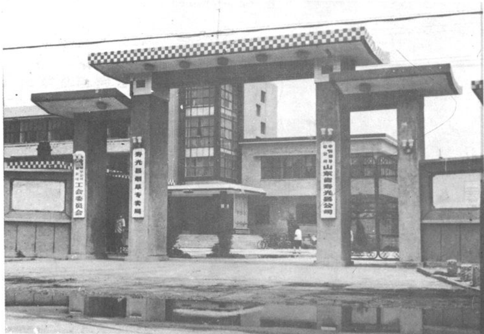
△山东省烟草公司寿光支公司大门
