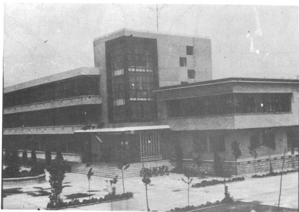
△山东省烟草公司寿光支公司办公楼
