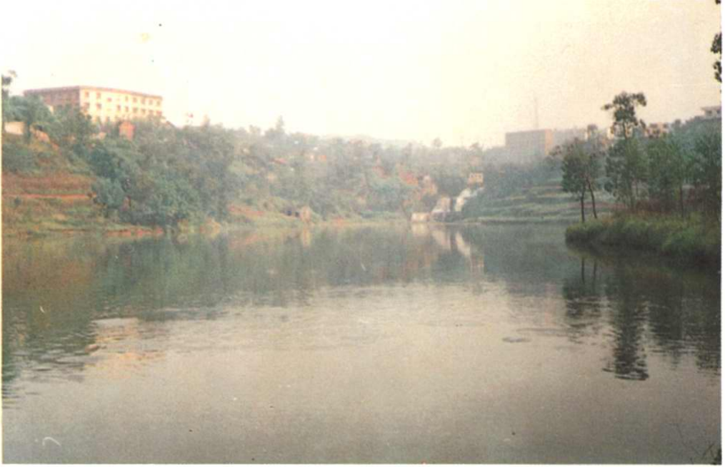
高滩岩水库1965年建成，占地56.8亩、蓄水15万立方米
