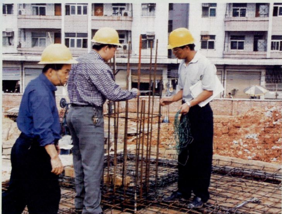
东莞市防雷设施检测所人员对在建建筑物防雷设施的施工质量进行检测。
