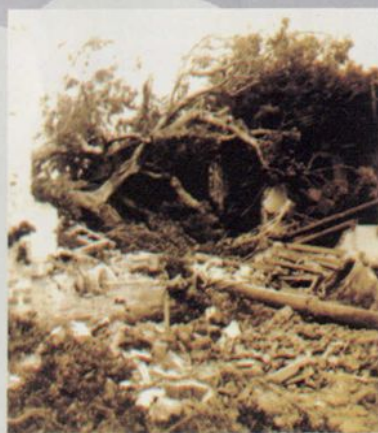
1979年4月19日，被龙卷风吹翻的大榕树压塌厚街白蚝大队部及幼儿园的房屋。
