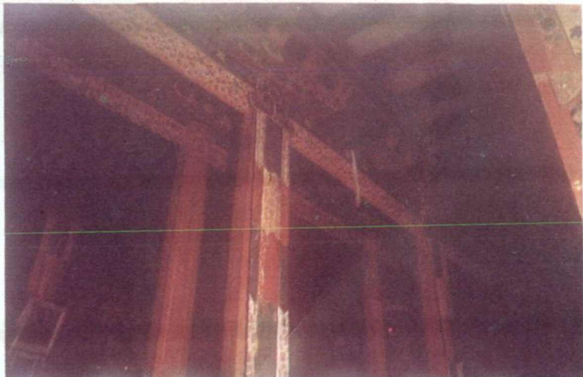
图六：“乌孜”大殿中层佛殿的柱子
