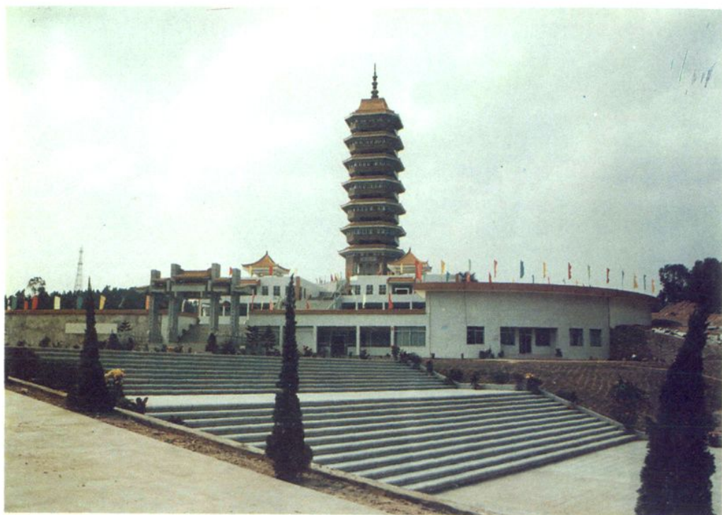
三水区纪元塔、博物馆外景
