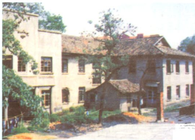
1958 年兴建的门诊部
