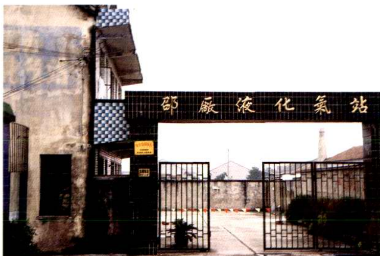
邵厂液化气站
