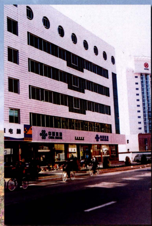
新建的联通分公司大楼
