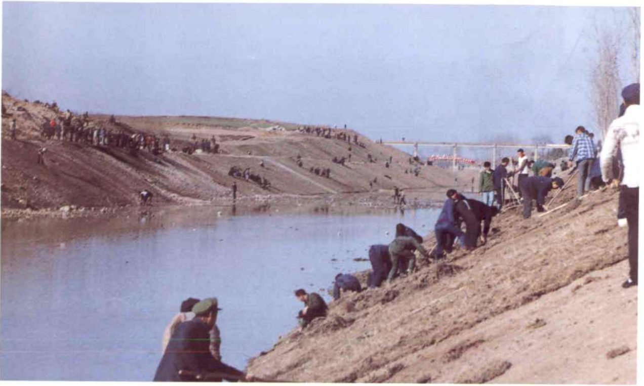
总干渠续建改造中的标准化整修
