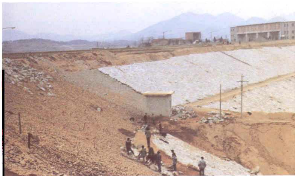
主坝河槽左段 加固施工
