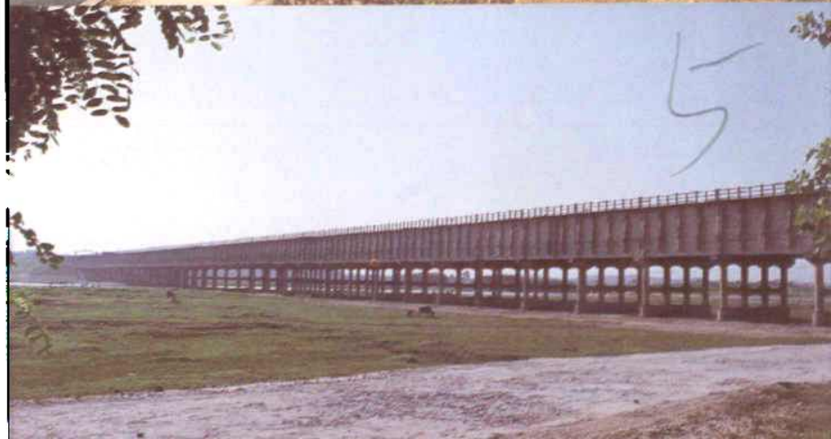
总干渠灌河渡槽 李德武摄
