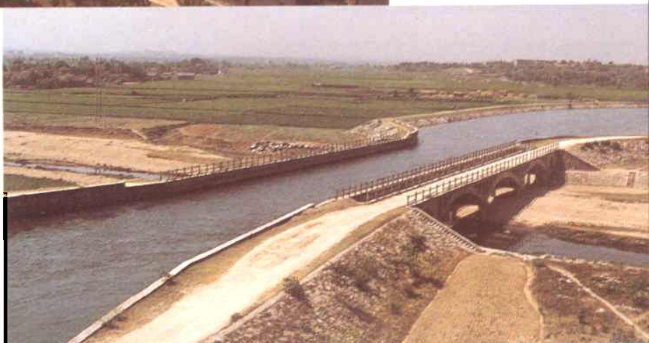
总干渠陶家河渡槽 李德武摄
