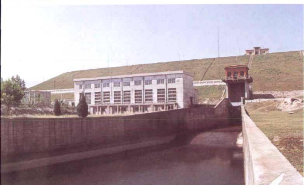
输水洞出口与 水电站厂房
