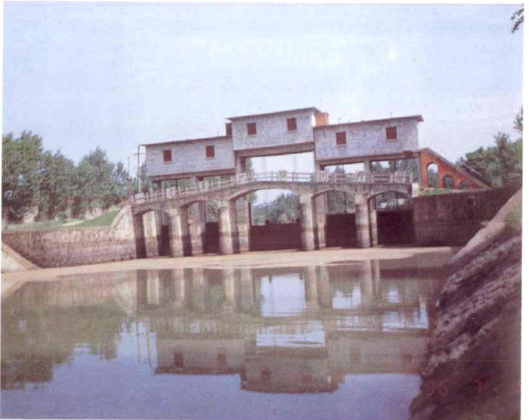
总干渠在东干渠分水闸处的节制闸
