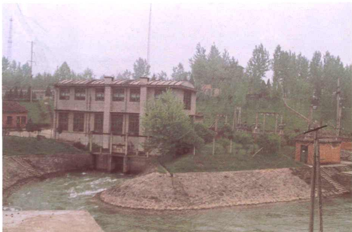
中干渠迎水寺岗水电站
