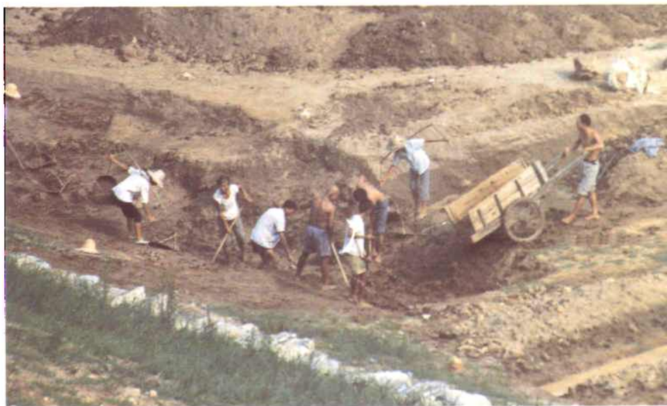
8号副坝加固施 工清理基础
