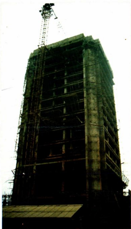
建设中的毕节地区商业贸易中心
