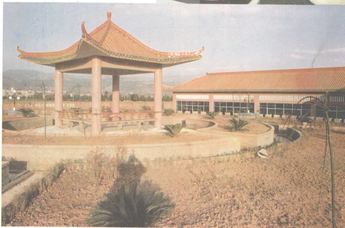
园林式的城南供水加压站
