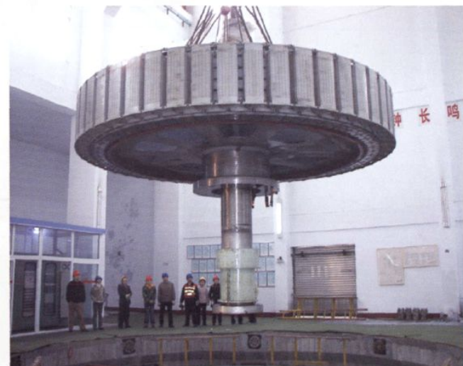
螺丝池水电厂发电机组维护
