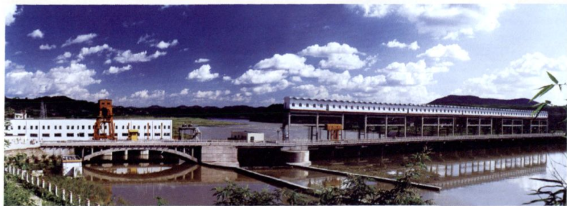
金华水电厂近景
