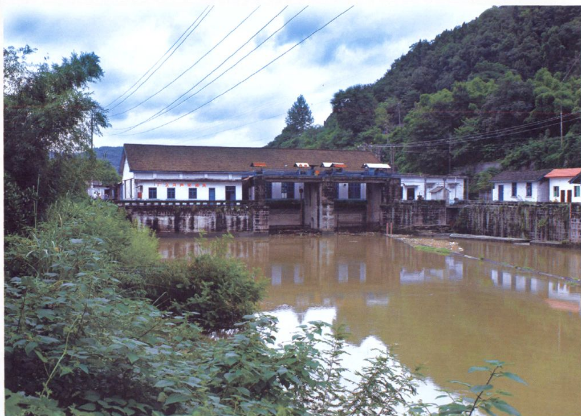
东风电站厂房、前池
