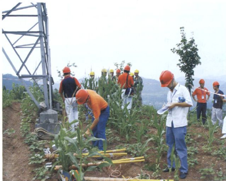
输电线路施工
