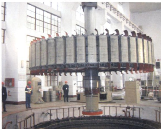
金华水电有限责任公司3G转子吊装
