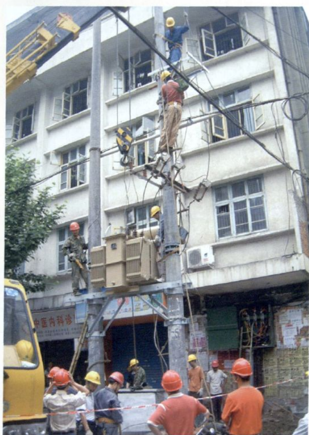
公司开展迎峰渡夏施工作业
