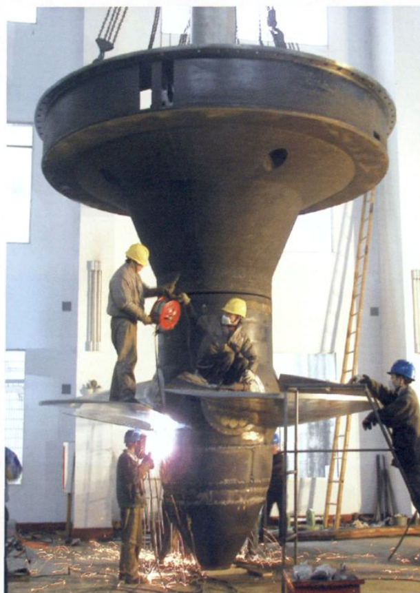
金华水电有限责任公司发电机组检修
