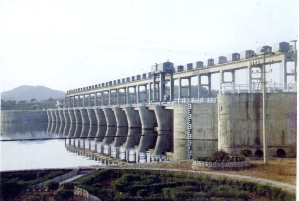
螺丝池水电厂涪江闸坝
